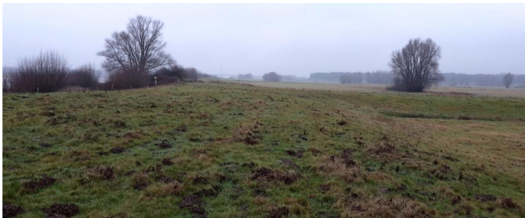
Figuur 1.3 Zomerkade ter hoogte van gasleidingdam met aan de linkerkzijde de Waal, kijkend in noordwestelijke richting.
