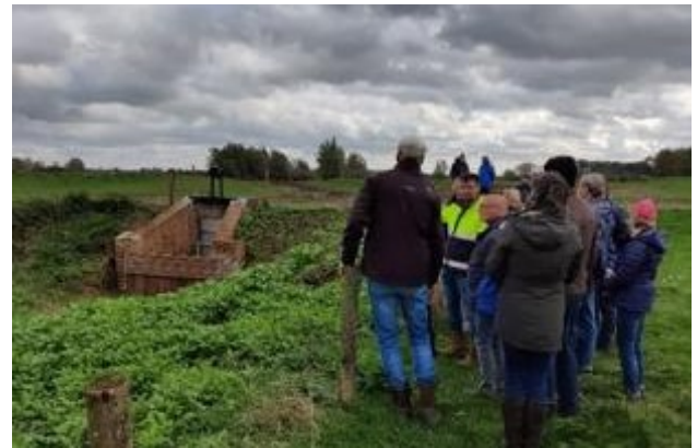
Technisch Manager Koen Akkers van Rijkswaterstaat informeert de wandelaars over de renovatiewerkzaamheden aan het sluisje bij de Spaanse Schans
